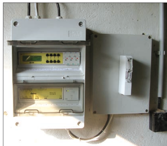
Obr. 3. Ve dřevozpracující firmě byl instalován hlídač maxima (digiwatt, vlevo), poskytující základní vyhodnocovací funkce. Jednodušší verze regulátoru je určena k regulaci ve třech stupních. Digitální vstupy kW·h a nulovací, bez připojení na PC nebo tiskárnu. Složitější je pak mikroprocesorová jednotka určená k měření, vyhodnocování a ve spojení s výstupními moduly k regulaci 1/4 hodinového, resp. technického maxima v sedmi stupních. Digitální vstupy kW·h, nulovací, kVAri, kVArc, popř. B12. Možnost připojení PC nebo tiskárny. Modul je určen pro „bezdrátové“ regulační zásahy v místech, kde je nemožné nebo finančně náročné instalovat ovládací kabely. Dálkové ovládání je realizováno frekvenční modulací na stávající NN vedení.
